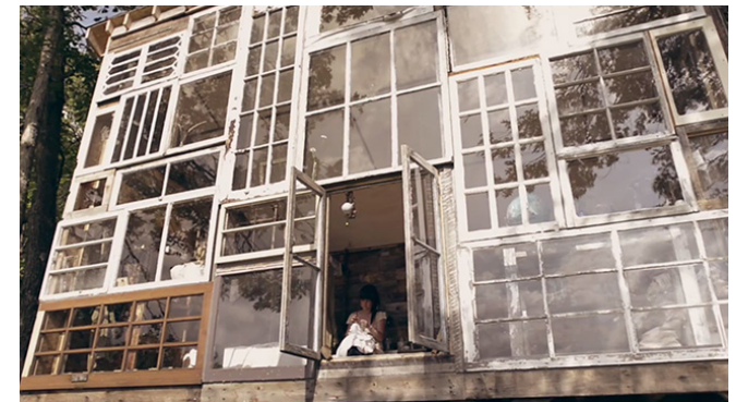
Gevel van gerecyclede kozijnen
