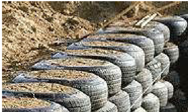
Banden onder talud om grond vast te houden
